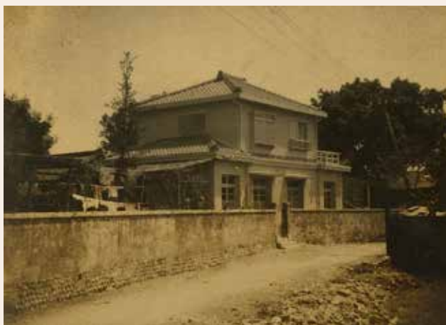
新建賴和醫院東側一景。賴和居室位於二樓，一樓為診療室、接待室。
