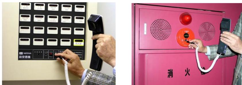
圖 2-31 總機與火警發信機電話插孔
